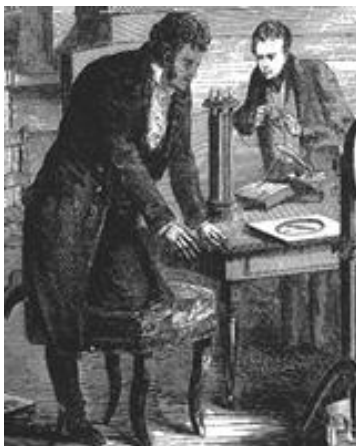
Fig. 1 : expérience d'Ørsted ; lorsque qu'un courant traverse un fil situé à proximité d'une boussole, l'aiguille aimantée est déviée d'un angle lié à l'intensité du courant.
